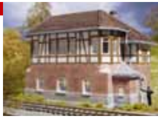
HC 8001 Cabina comando scambi e segnali Stellwerk Signal box
